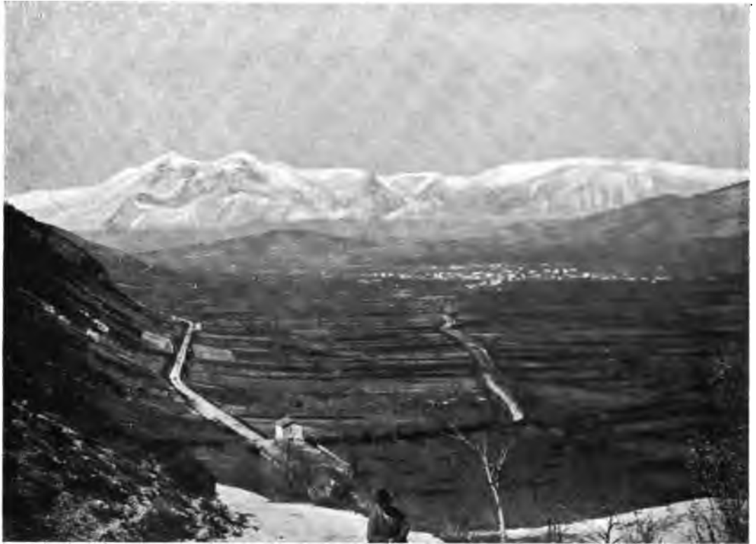
LA CONCA D'AVEZZANO COL MONTE VELINO, VISTI DAI TRE CUNICOLI.
